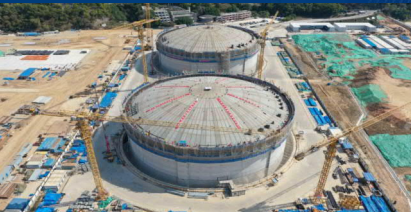
Сооружения для хранения материалов
